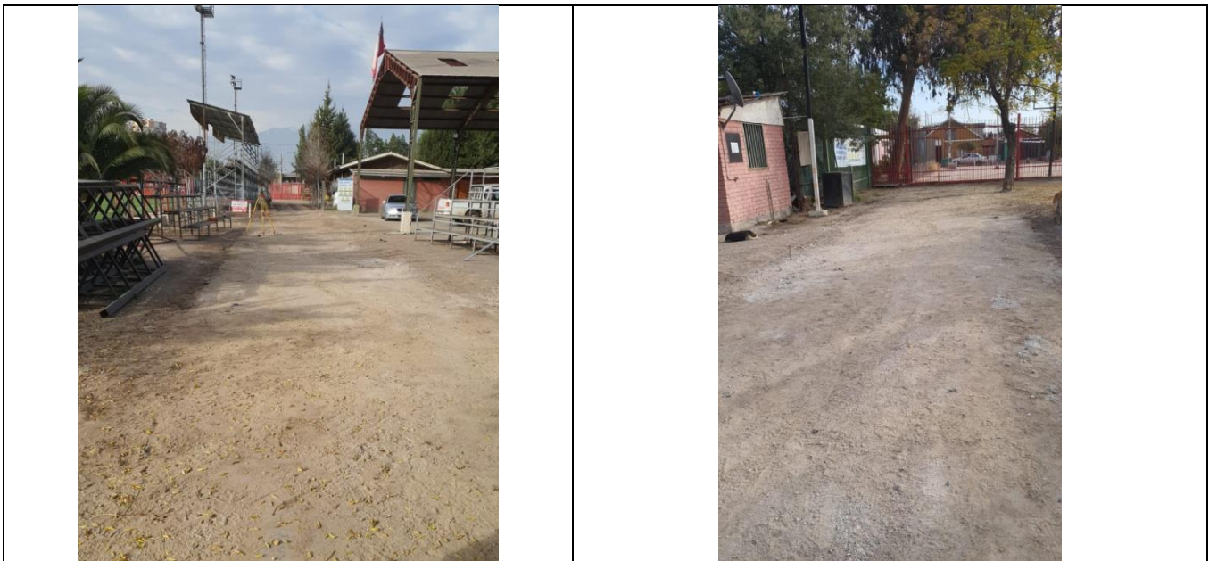
Demolición de pavimentos en mal estado para su reposición
