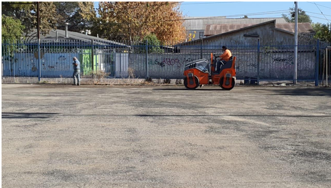
Preparación superficie deportiva
