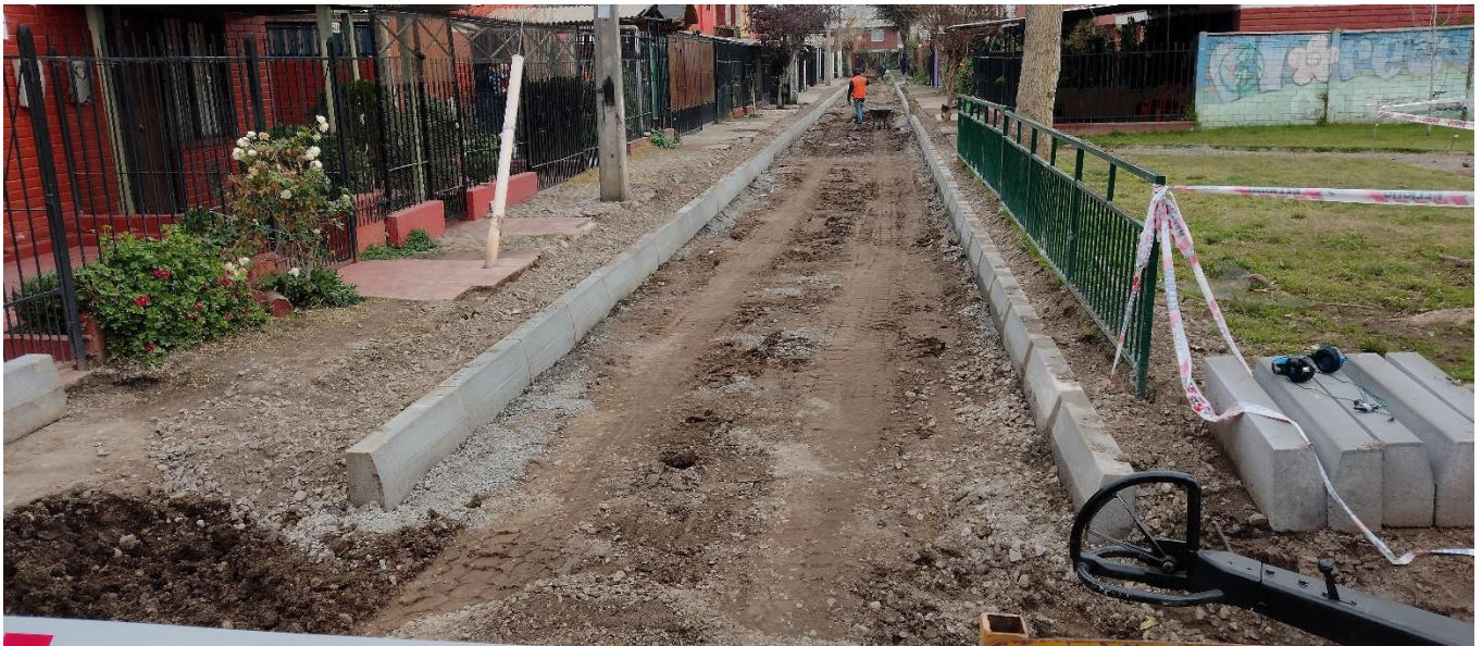
PAVIMENTACIÓN PASAJES Proyecto y pavimentación de pasajes en Estación Central.
